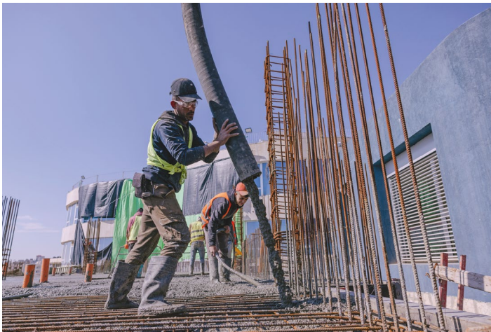
Il primo solaio intermedio è in fase di realizzazione.
